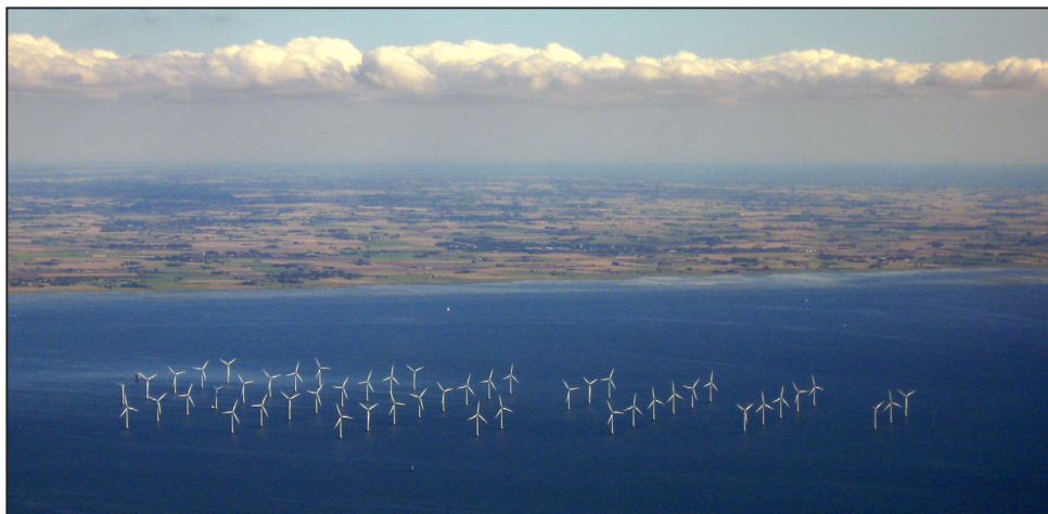
El Parque Eólico de Lillgrund, propiedad de la empresa estatal sueca Vattenfall, está situado a unos 10 km de la costa del sur de Suecia. Con 48 turbinas eólicas y una capacidad de 110 megavatios (MW), Lillgrund es el parque eólico marino más grande de Suecia y satisface la demanda de electricidad doméstica de más de 60.000 hogares.
